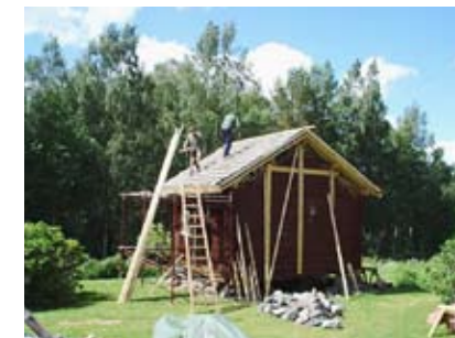
Betongpannorna och stickspånen på taket kasserades och ersattes med brädtak och begagnat lertegel.
