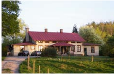
Boningshuset på Esset är en salsbyggnad som är byggd år 1870.
