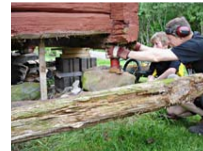
Några av syllarna på visthusboden behövde bytas ut. Här har rötskadat timmer avlägsnats och boden hålls tillfälligt uppe med hjälp av domkraft.
